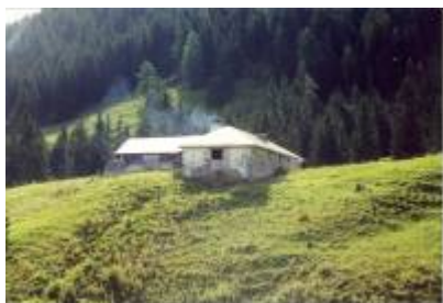
RF Antaines Dessus 1482m-1
